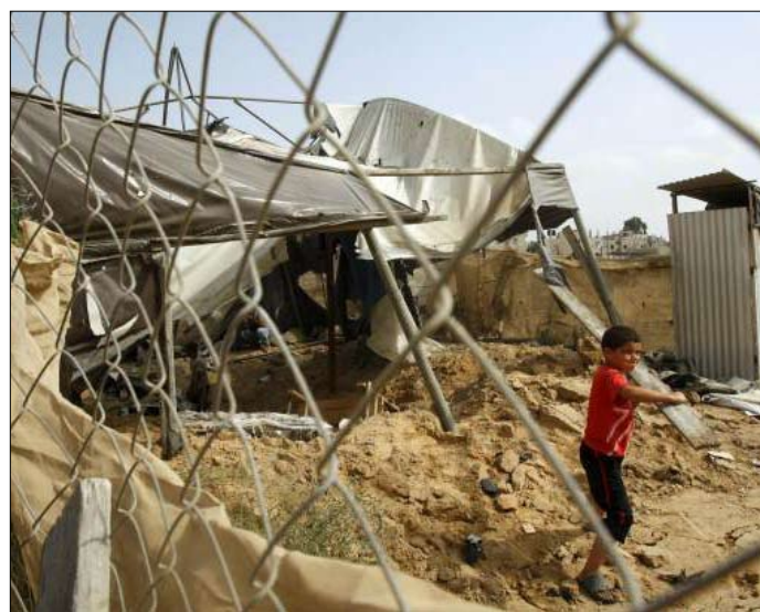
حطام انفاق دمرتها طائرات الاحتلال في غزة أمس (ابراهيم ابو مصطفى - رويترز)
