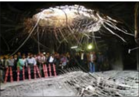
ملجأ الهامرية 1991: القنبلة الإفرافية حققت المحدثت حتى الملاجئ السفلية (المصدر: المرعي الجديد)
