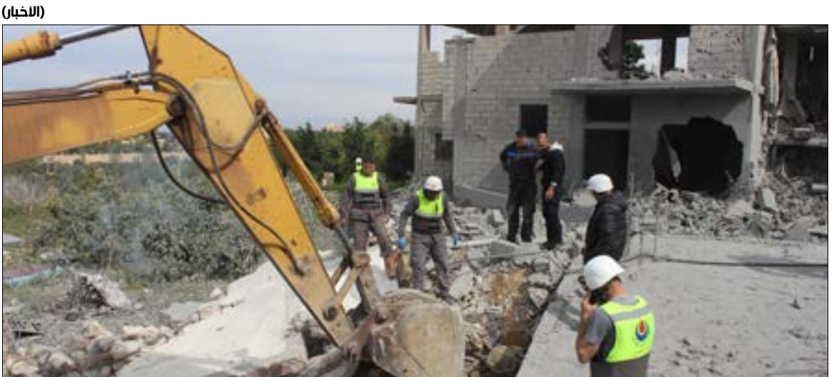
البناء في بنت جبيل
